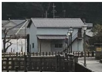
改修前(旧倉庫)
